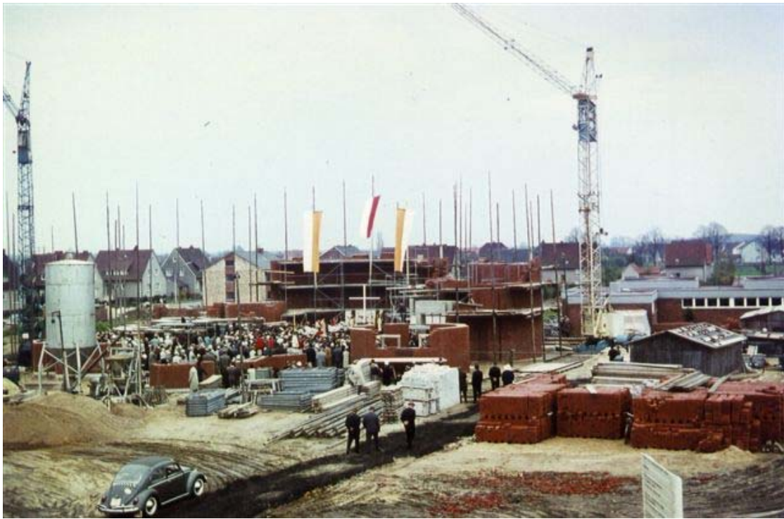
Bild 3: Die Baustelle der Johanneskirche am Tag der Grundsteinlegung 1965 (Foto: Herbert Ernst)
